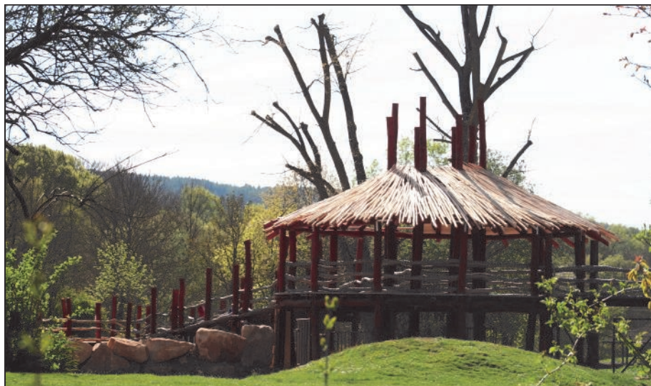
Zastřešení vyhlídky na lávce. (sj)
