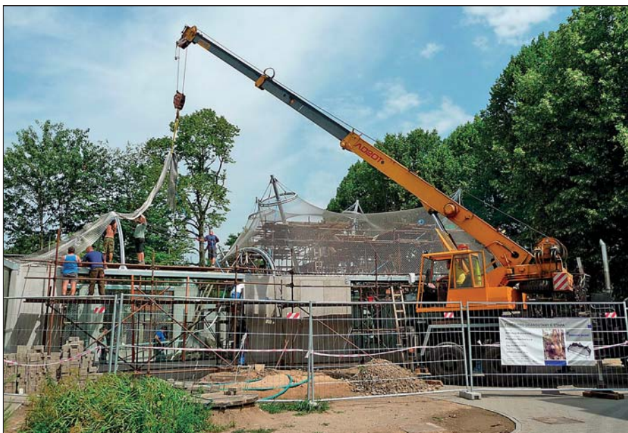
Montáž sítě zastřešení výběhu pro orangutany II.etapa. (vm)
