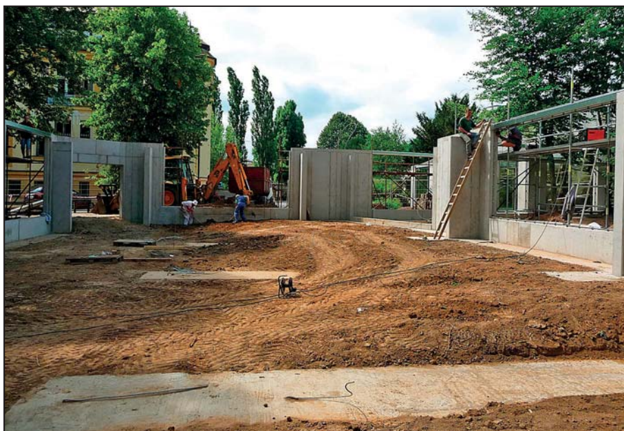
Obvodové konstrukce výběhu pro orangutany II.etapa. (vm)
